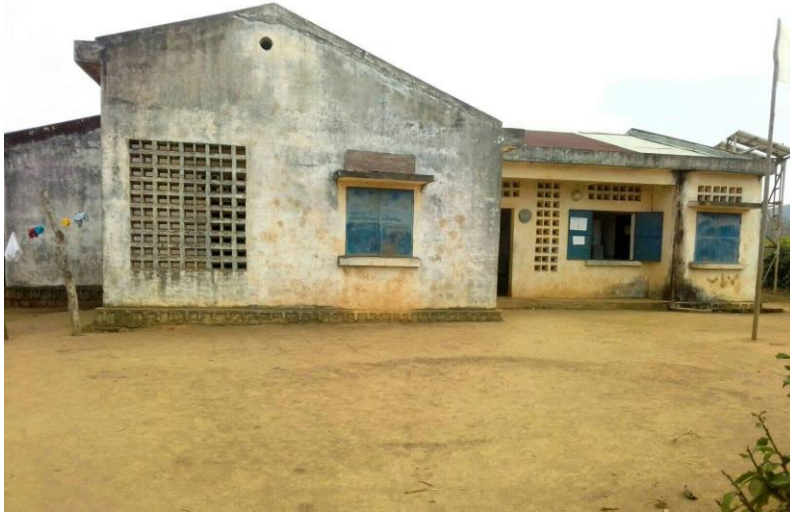
Photo 5 : Aperçu de l'infrastructure sanitaire de Lavaraty
